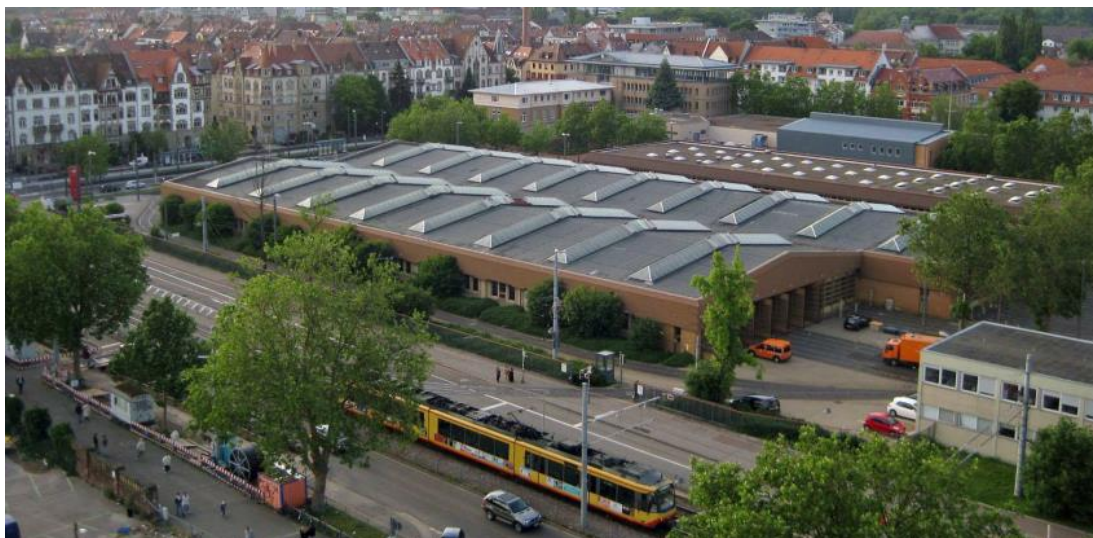
Abbildung 3: Blick von der Durlacher Allee auf die Wagenhallen des Betriebshofes (Quelle: Auslobung zum Realisierungswettbewerb)
