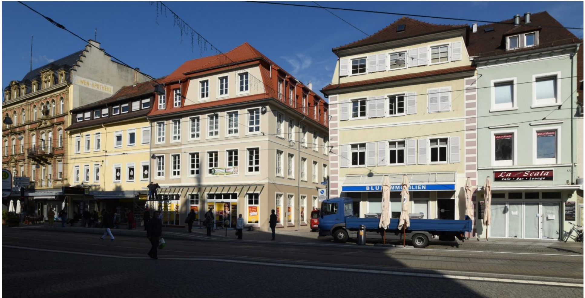
Pfinztalstraße 26 - An den gestalterischen Festsetzungen orientierter Neubau
