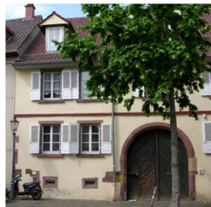
Beispiel Fassade mit Tor und Fenster
