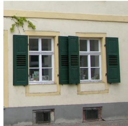
Beispiel Fenster / Klappläden
