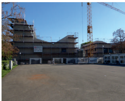
Baustelle des Petrus-Jakobus-Gemeindezentrums am Walther-Rathenau-Platz
