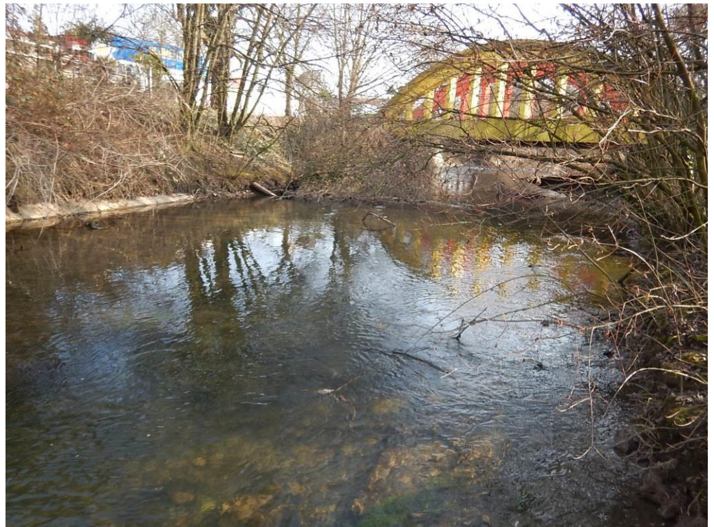
Bild 2 Pfinz unterhalb Pforzheimer Straße, Ufersicherung Mit Beton
