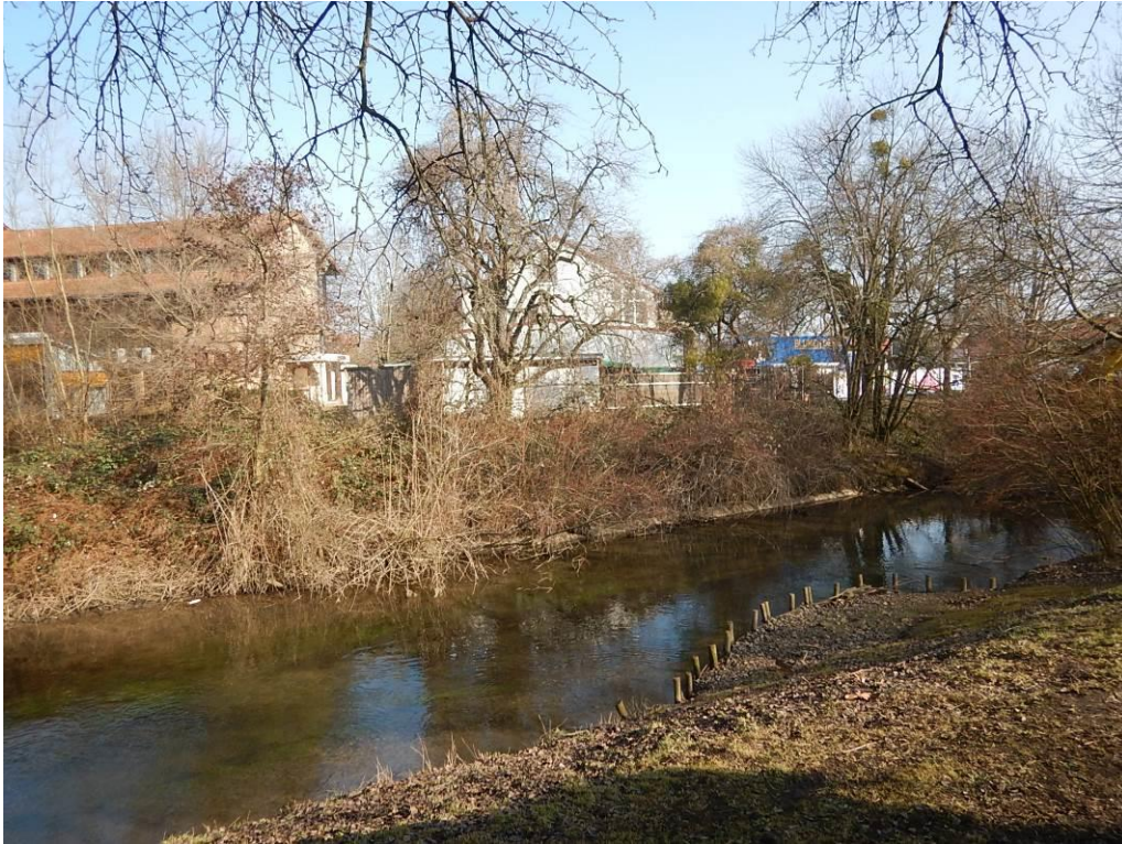
Bild 1 Pfinz im Bereich des Flechtzauns, Ufersicherung
