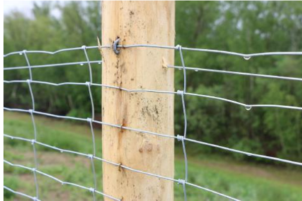
Pfosten bestehen aus haltbarem Robinienholz.
