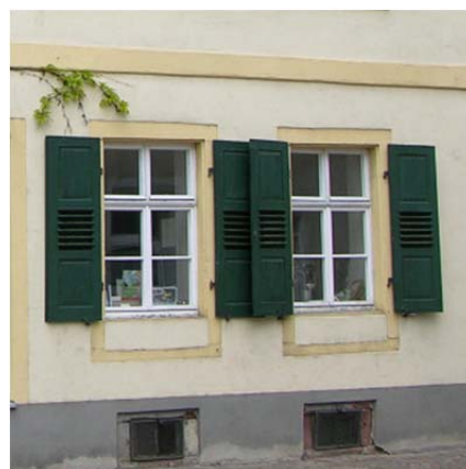
Beispiel Fenster / Klappläden
