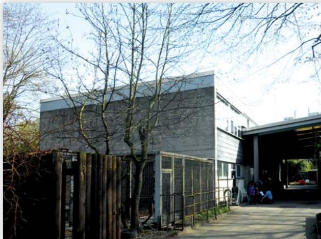
In der **Milchbar** sollte eine Lüftung eingebaut werden beziehungsweise als zusätzliche Maßnahme der Wirtschaftsbereich gedämmt werden, um das Raumklima zu verbessern. Kurz- bis mittelfristig wird die Trinkwasserversorgung erneuert werden müssen, da die Rohre noch aus verzinktem Stahl bestehen. Das Heizungsnetz mit den Wärmekörpern soll überprüft werden, da es bereits starke Korrosionsansätze gibt.
