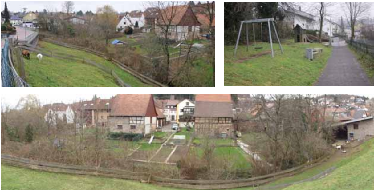
Abbildung 37: Ausgangssituation im Bereich der Hanglage
