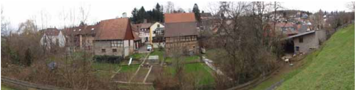
Abbildung 16: Freiraum entlang des Wettersbachs
