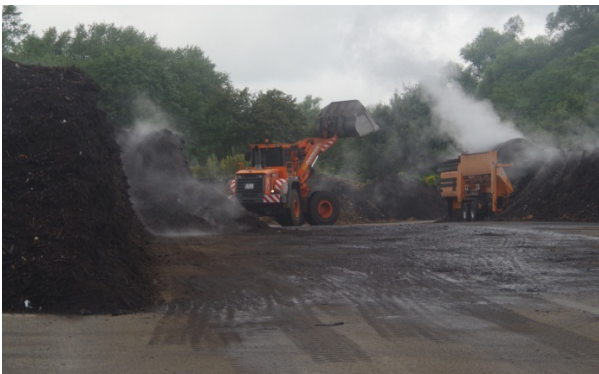
Abbildung 40: Kompostierungsanlage Knielingen und Beschickung des Häckslers
