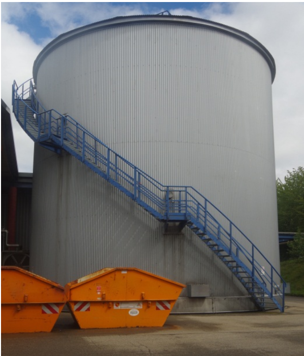
Abbildung 39: Gärturm der Nassvergärungsanlage
